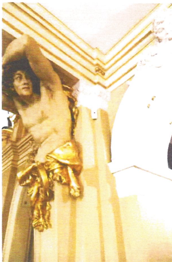
Fot. 4. Zbliżenie – ściana pld.-wsch. foyer (widoczna czujka). 2017r.
