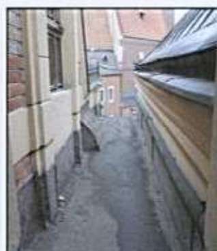
Obróbki blacharskie wykonane z blachy miedzianej
