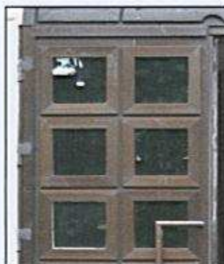
Stolarka nowa (drzwi i okna) - aluminiowa w kolorze brązowym.
