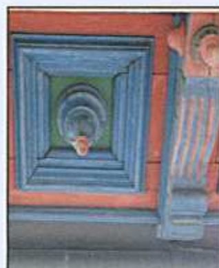
Drewniana dekoracja okapu wieży – strop belkowy - drewno sosnowe i bukowe (rekonstrukcje), polichromowane (farby do drewna Brillux 2 )
