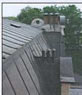
Obróbki blacharskie wykonane z blachy miedzianej
