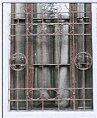
Metaloplastyka – ozdobna krata stalowa w oknie trójdzielnym parteru wieży (elewacja wschodnia).
