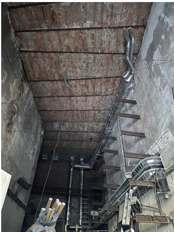
Zdj.10. Wnętrze pomieszczenia archiwum, strop Kleina | Zdj.11. Przejście do przedsionka w części centralnej budynku
