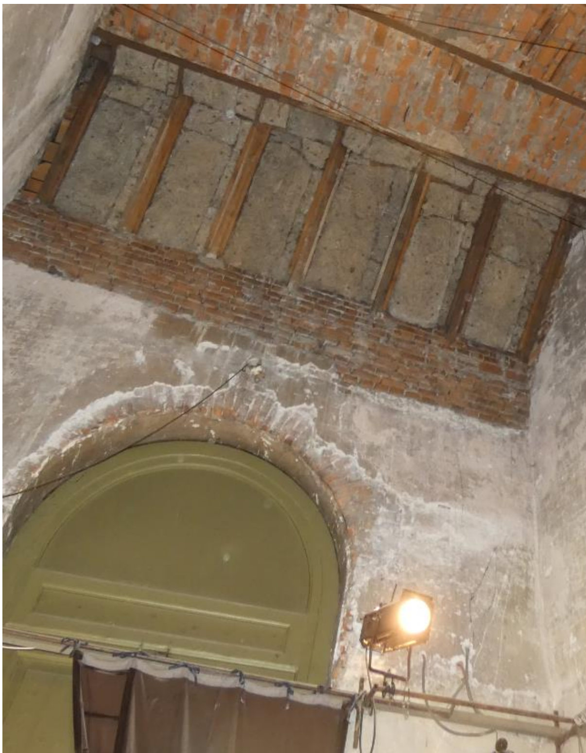
Fot.8 Fragment ukośny stropu nad помещением magazynu
