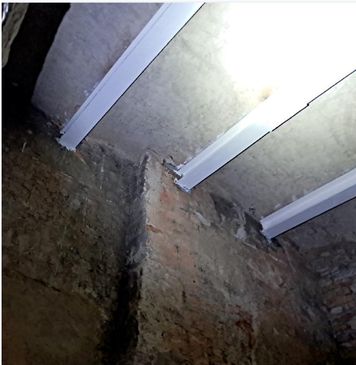
Fot.7 Strop odcinkowy nad piwnicą w części południowo-wschodniej
