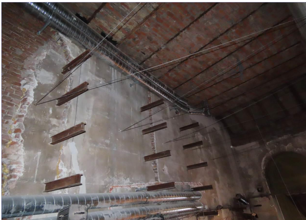
wnętrze archiwum zachowane tynki i eksponowane wązki ceglane – głównie strop Kleina, ponadto drewniana brama i zablendowane drewnem naświetle w łuku ceglanym; stan obecny
