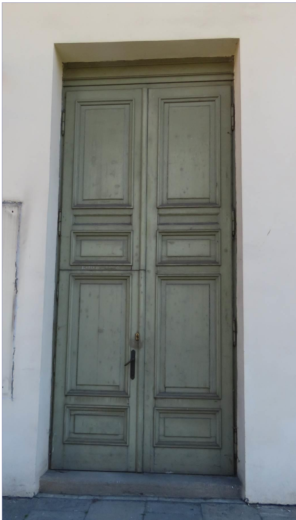
Widok od strony elewacji stolarka drzwi dwuskrzydłowych z furtką , wymienione klamki i szyldy na współczesne; stolarka malowana w kolorze stonowanej zieleni oliwkowej
