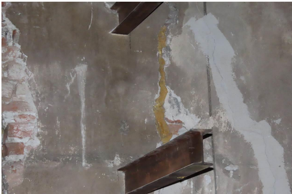
fragment ściany tynkowanej od zachodu - lokalnie widoczne wzmocnienia spękań tynków wątków zaprawami gipsowymi wapienno cementowymi oraz doraźne zakładanie w spękania pianki montażowej, rdzewiejące metalowe elementy wmontowane w ściany; liczne instalacje urządzenia biegnące na tynkach, montowane w murach, odkrywki konserwatorskie
