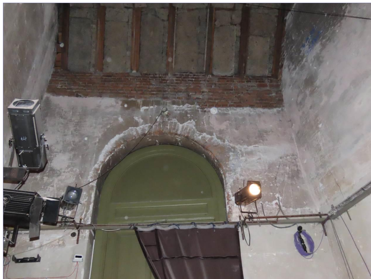
wnętrze archiwum zachowane tynki i eksponowane wązki ceglane – głównie strop Kleina, ponadto drewniana brama i zablendowane drewnem naświetle w łuku ceglanym; stan obecny
