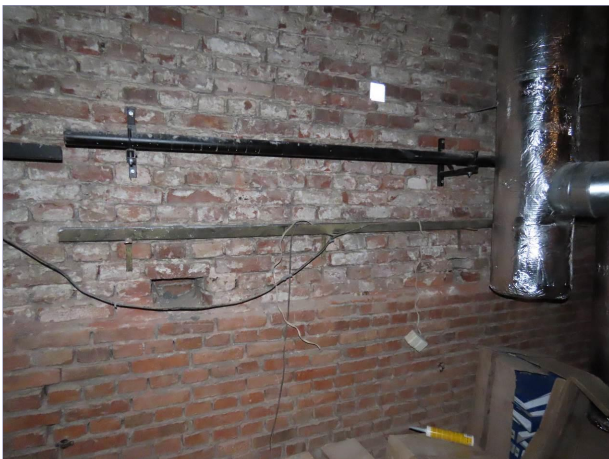
zaprawy naprawcze na ceglanych włatkach, zardzewiałe elementy konstrukcji na stropie; zróżnicowane włatki na ścianach (pod południa) bez tynków
