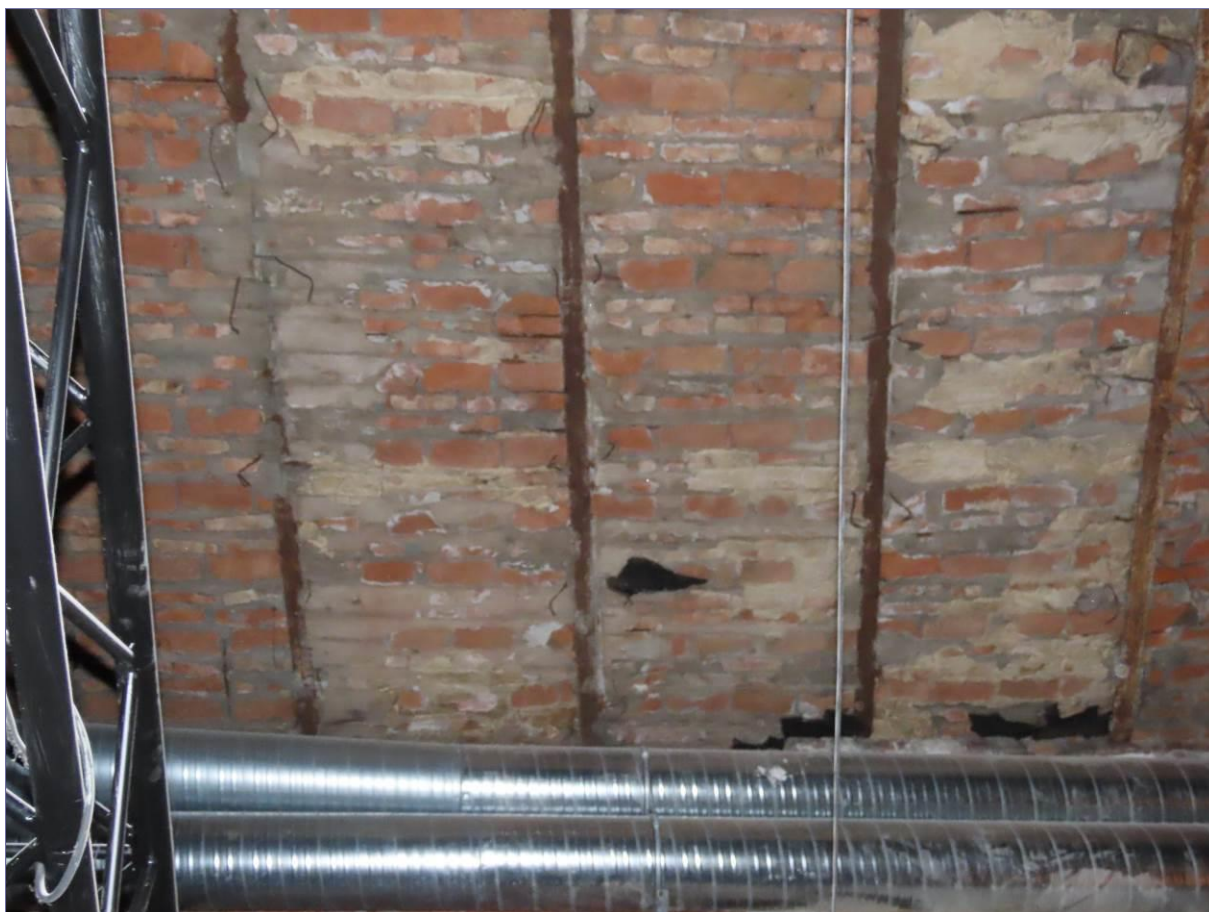
zaprawy naprawcze na ceglanych włatkach, zardzewiałe elementy konstrukcji na stropie; zróżnicowane włatki na ścianach (pod południa) bez tynków
