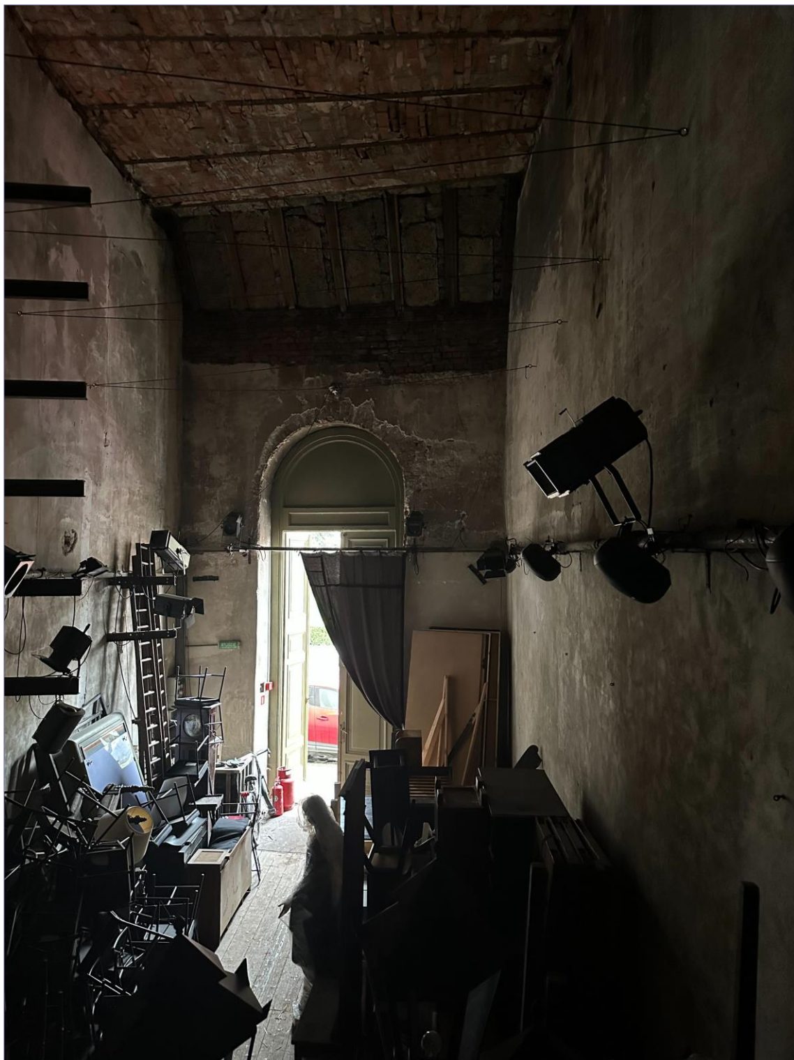
wnętrze archiwum-widok w kierunku północnym na wyjście na ulicę – zachowane tynki i eksponowane wówki ceglane – głównie strop Kleina, ponadto drewniana brama i zablendowane drewnem naświetle w łuku ceglany; foto archiwum Inwestora pocz. XXI wieku
