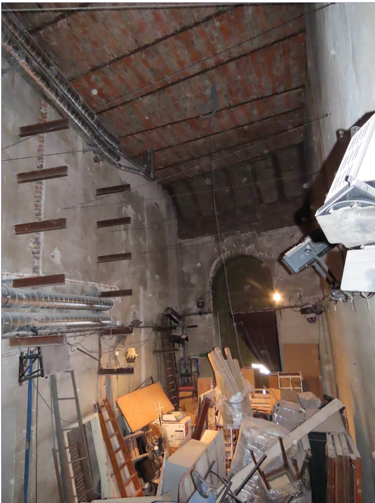
wnętrze archiwum widok w kierunku północnym na wyjście na ulicę – zachowane tynki i eksponowane wówki ceglane – głównie strop Kleina, ponadto drewniana brama i zablendowane drewnem naświetle w łuku ceglany; stan obecny
