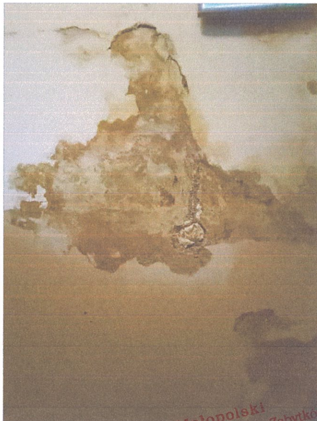
uszkodzenia tynków wskutek awarii rury spustowej odprowadzającej wodę deszczową wewnątrz murów tutaj korytarz południowy - korozja i degradacja tynków starszych i naprawczych
