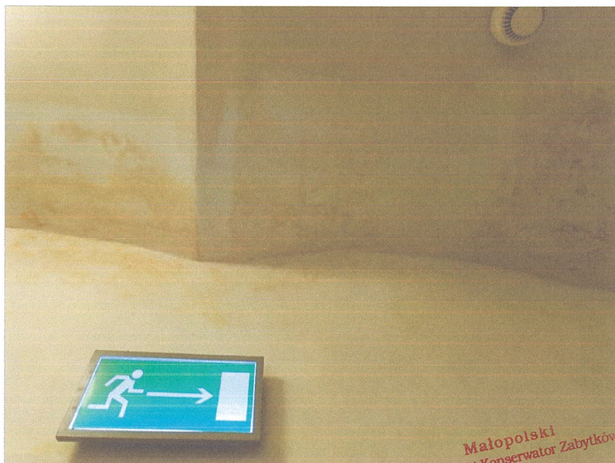
uszkodzenia tynków wskutek awarii rury spustowej odprowadzającej wodę deszczową wewnątrz murów - korytarz południowy korozja i degradacja tynków starszych i naprawczych
