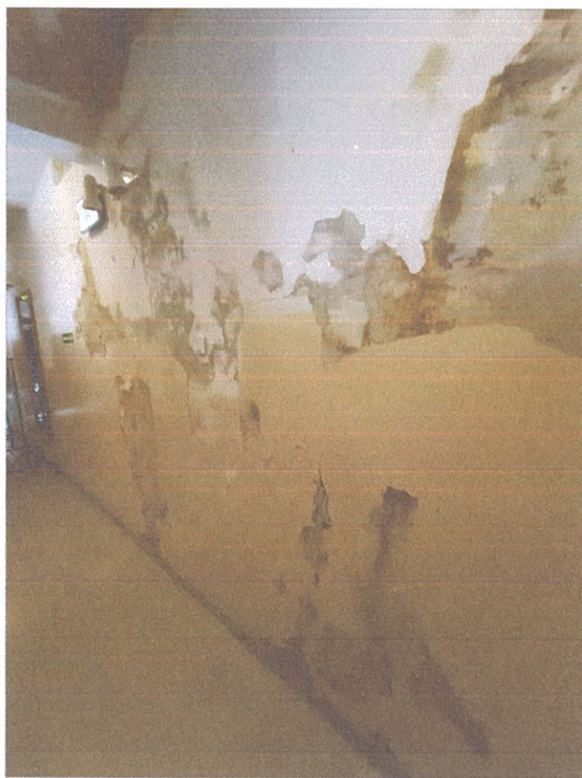
uszkodzenia tynków wskutek awarii rury spustowej odprowadzającej wodę deszczową wewnątrz murów tutaj korytarz południowy - korozja i degradacja tynków starszych i naprawczych
