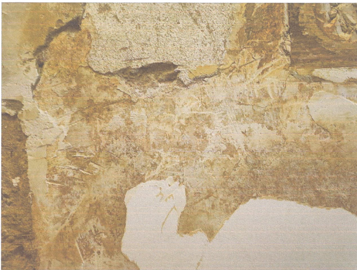
uszkodzenia tynków wskutek awarii rury spustowej odprowadzającej wodę deszczową wewnątrz murów - korytarz południowy korozja i degradacja tynków starszych i naprawczych
