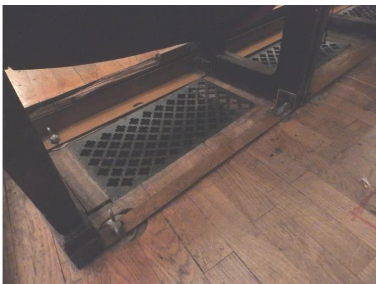
mosiężne kratki pod fotelami na widowni na parterze
