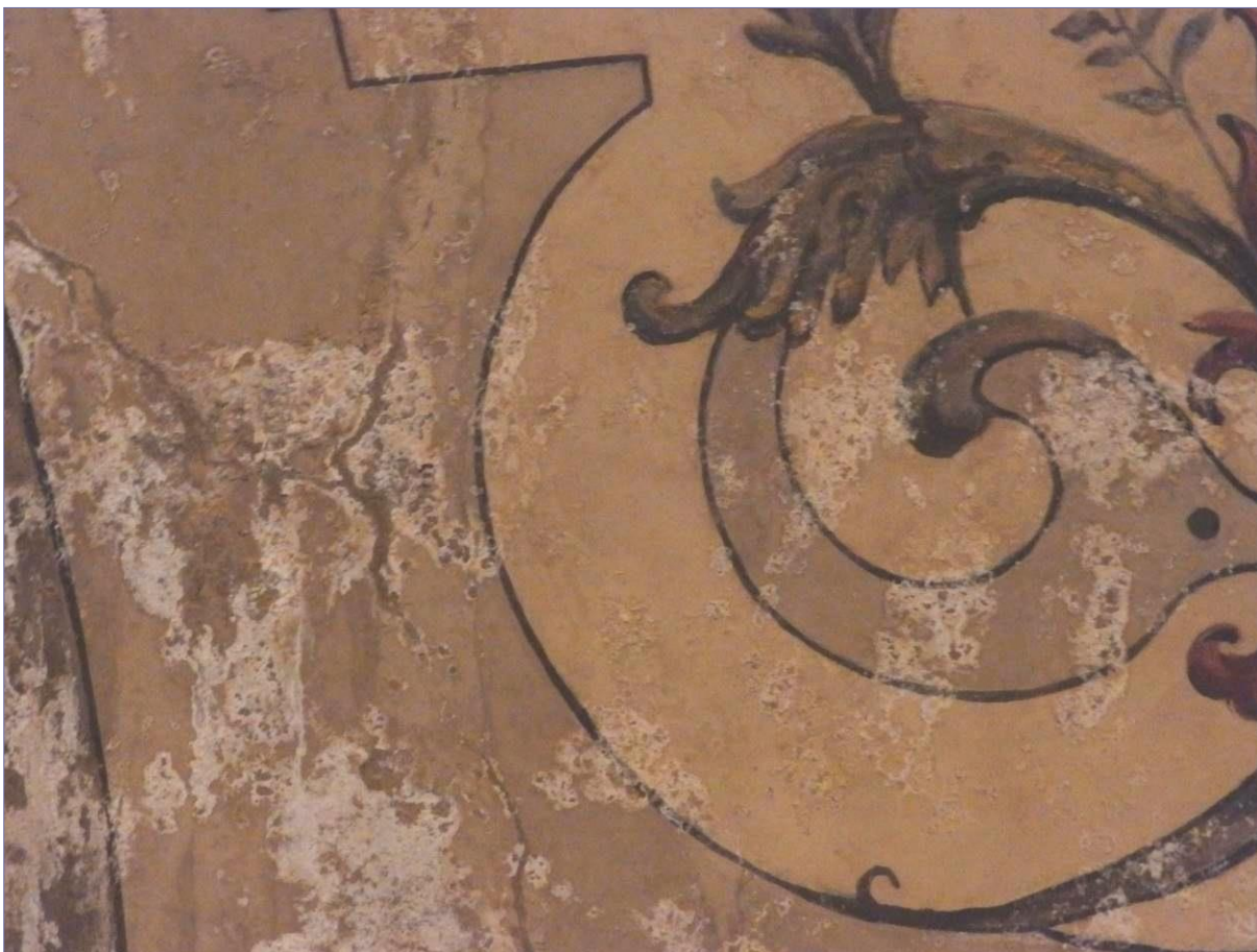
uszkodzenia pobiał i wypraw oraz warstwy malarskiej wskutek postania wysoleń
