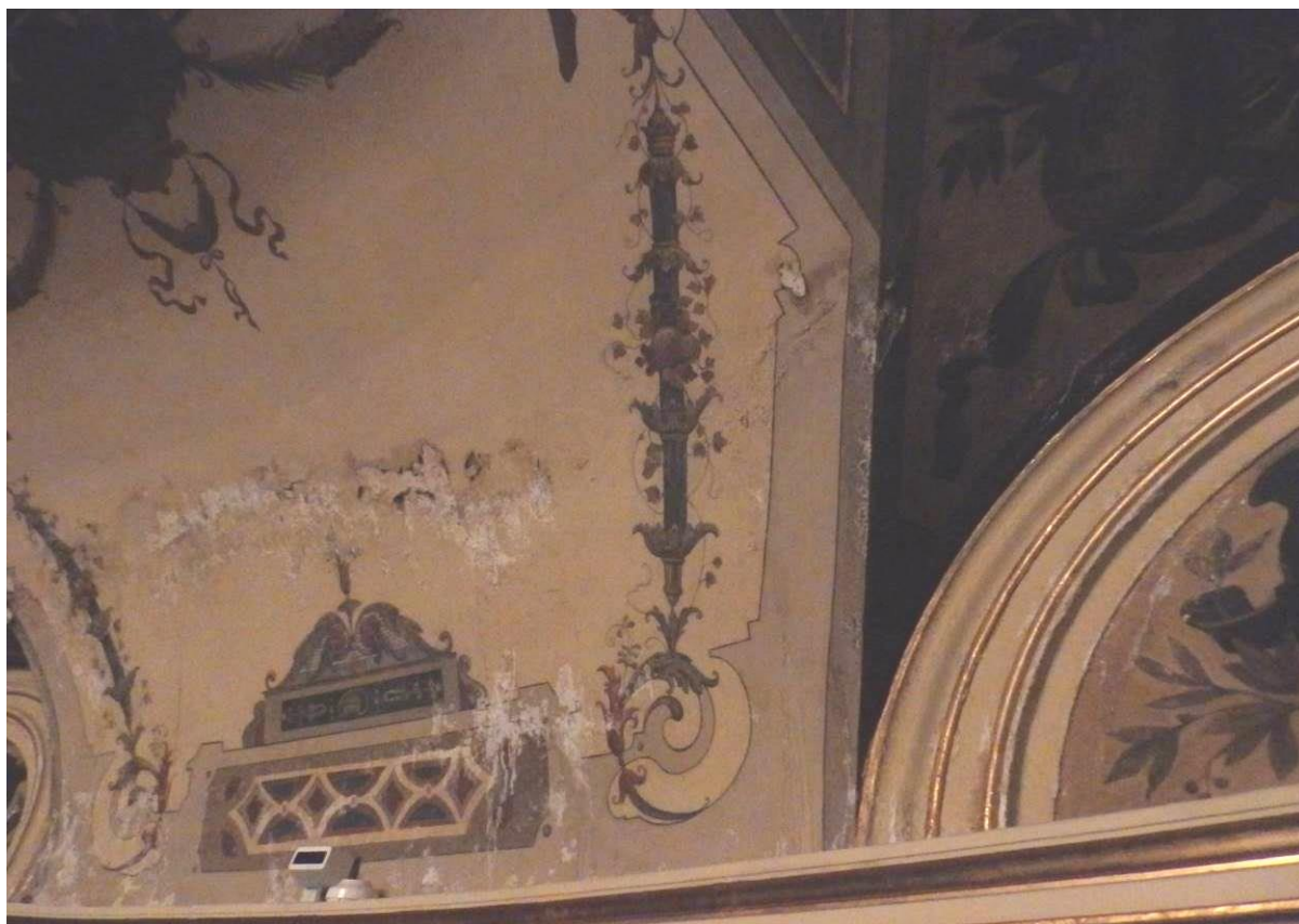
fragment spływu – uszkodzenia zapraw, pobiały oraz warstwy malarskiej spowodowane wysoleniami (po zalaniu)
