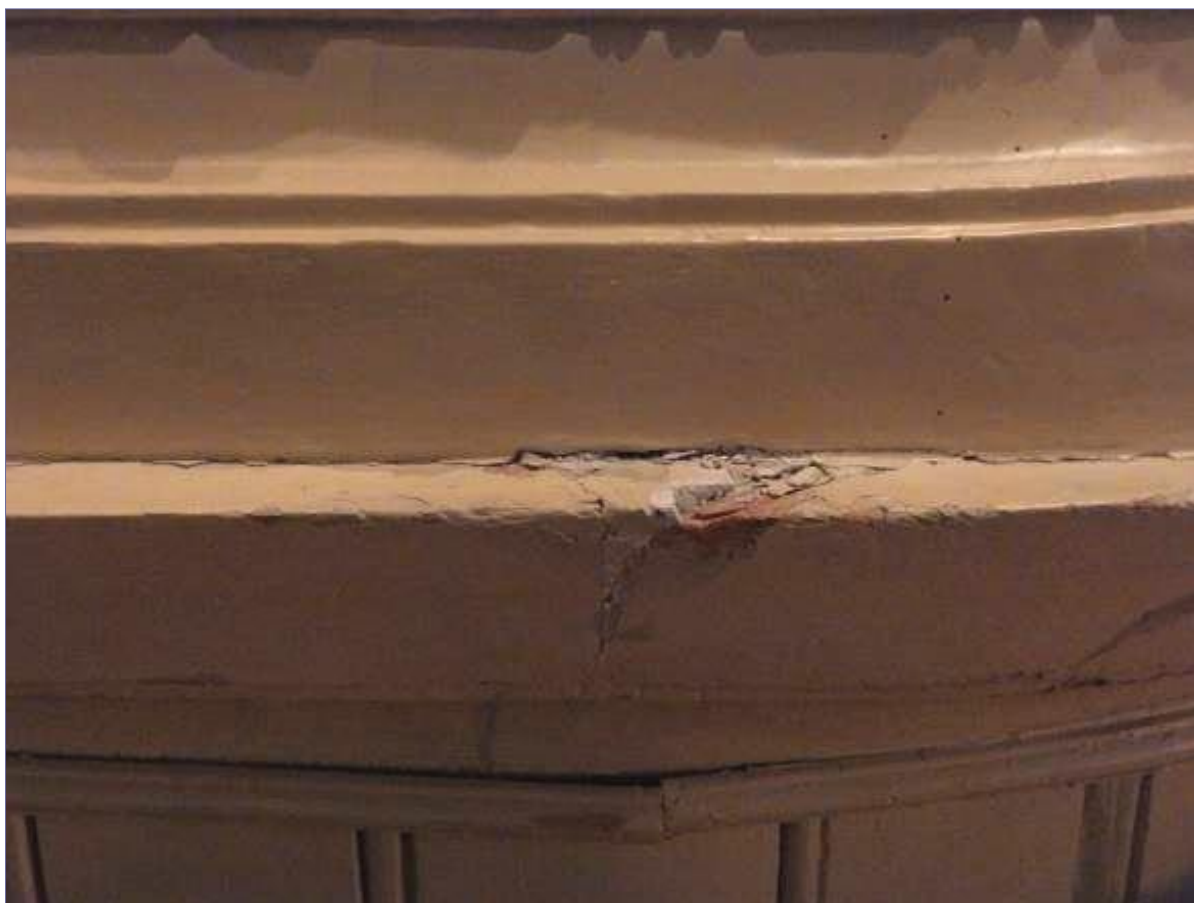
balustrada z boazerią - uszkodzenia drewna, spękania, oderwanie się listew, grube warstwy farb powodują przy lekkim uderzeniu odpryski; doraźne kity maskujące spękania
