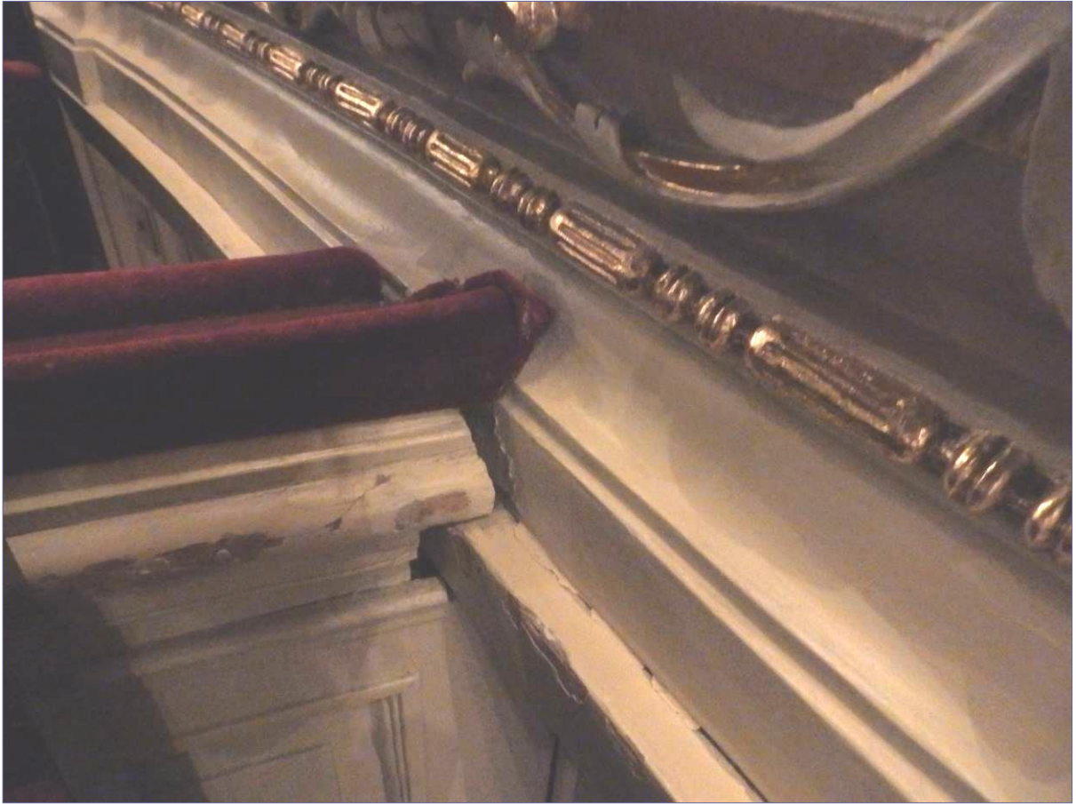
zniszczenia poszczególnych elementów – drewna stiuków, malatur i złoceń
