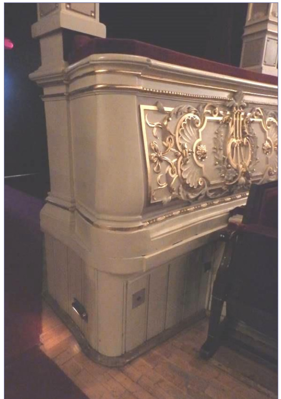
zniszczenia poszczególnych elementów – drewna stiuków, malatur i złoceń
