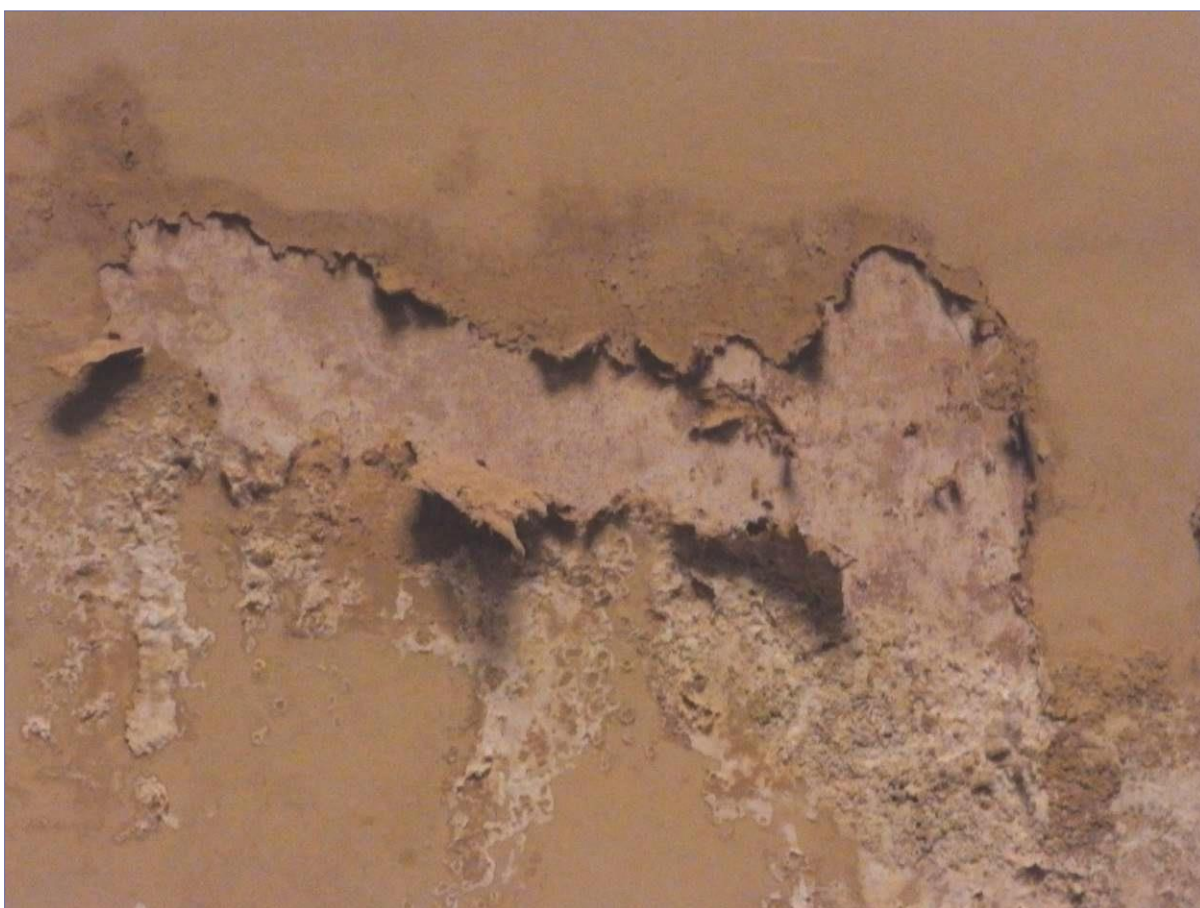
uszkodzenia pobiał i wypraw oraz warstwy malarskiej wskutek postania wysoleń
